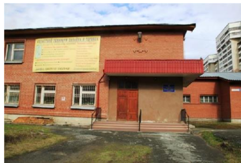
Учебный корпус Ул. Стахановская, 43
