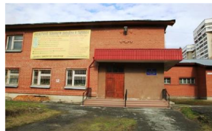
Учебный корпус ул. Стахановская, 43
